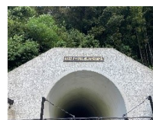
【新日下川放水路】
